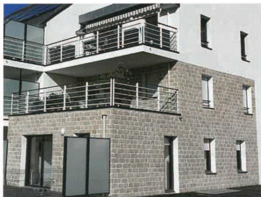
Taille éclatée, granit beige aux grain fins - Aspect rustique - Hauteur d'assise entre 13 et 18 cm et pose au rang.
